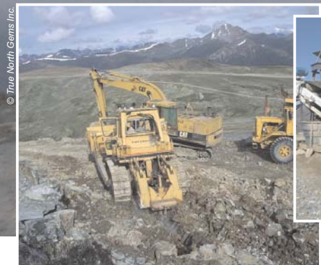
Travaux dans la tranchée de la propriété Tsa Da Glisza, au Yukon
