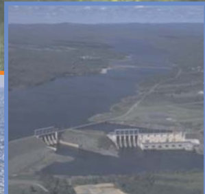
Barrage hydroélectrique de Mactaquac, Nouveau-Brunswick
