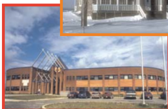
Exploitation de nos installations communautaires
