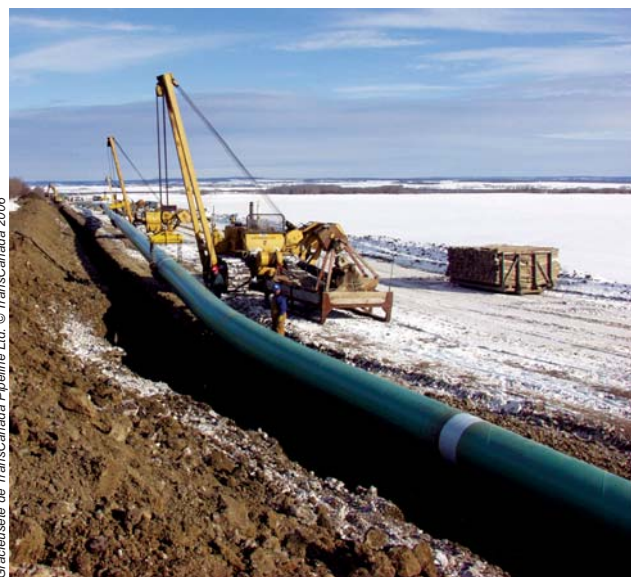
Installation d'un gazoduc
