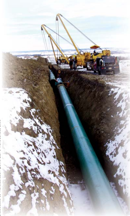
Installation d'un gazoduc
