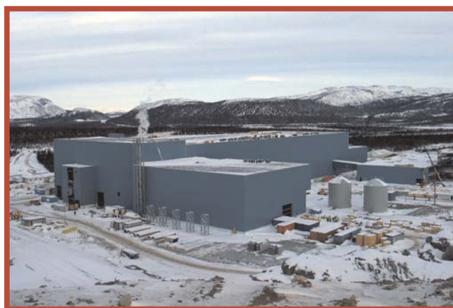
Usine de concentration, baie de Voisey, T.-N., novembre 2004
