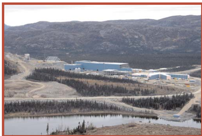
Usine de concentration et bâtiments annexes, baie de Voisey, T.-N., octobre 2004
