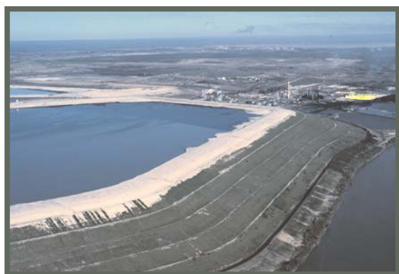
La rivière Athabasca et le bassin de décantation des résidus original de « l'île de bitume » de la mine de Great Canadian Oil Sands (GCOS; Suncor). Le coke (noir) et le soufre (jaune) sont deux sous-produits importants du traitement des sables bitumineux.
