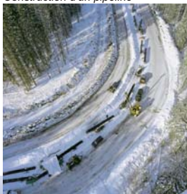
Construction d'un pipeline
